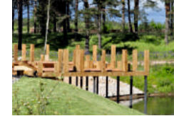
long metal piles
